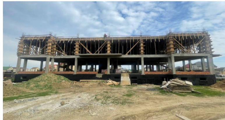
На сегодняшний день ведутся монолитные работы второго этажа и кладка стен первого.
